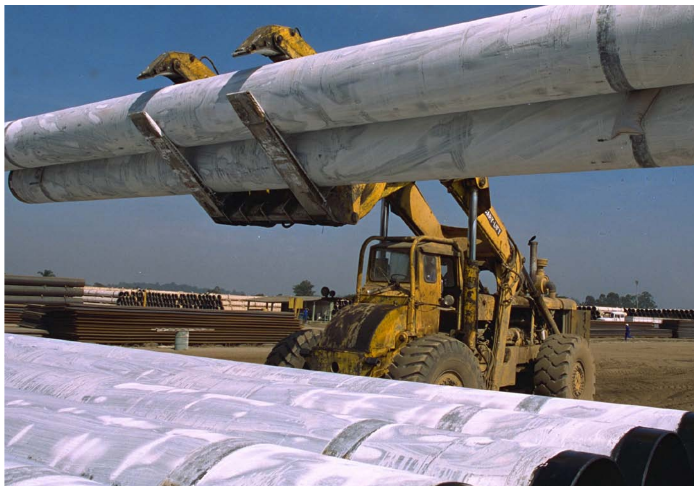
Dutos utilizados na construção do gasoduto Brasil-Bolívia
